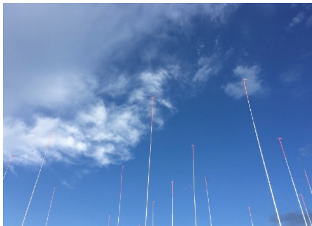
Bauvisiere für den geplanten Neubau Francesco.
